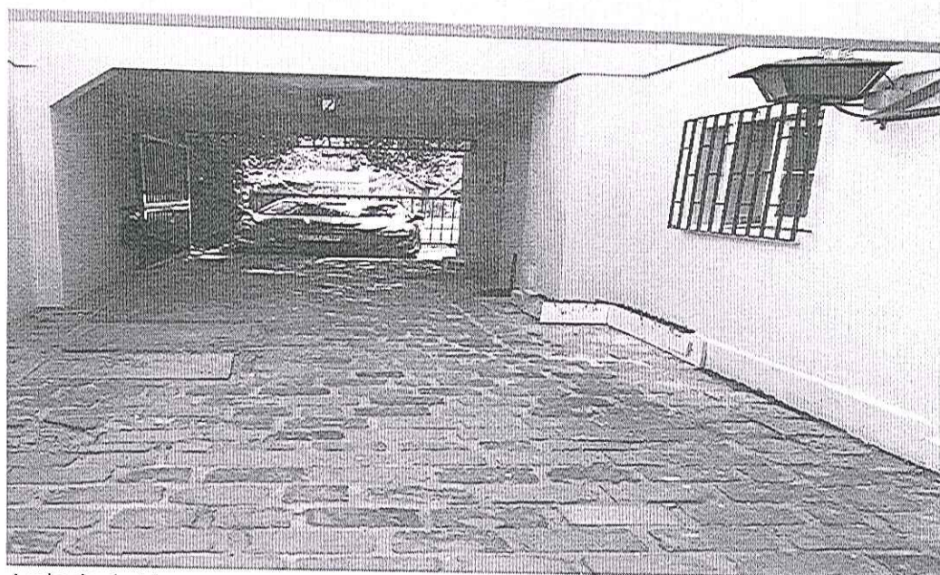
Acabado de Muro
