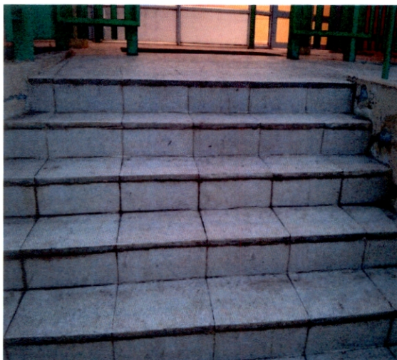
5. Peldaños de la entrada del jardín sin material antideslizante Jardín "Principito"
