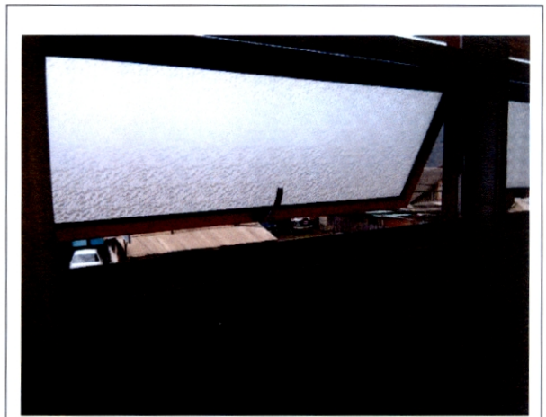
4. Ventana de baño de nivel medio sin malla mosquitera Jardín "Principito"
