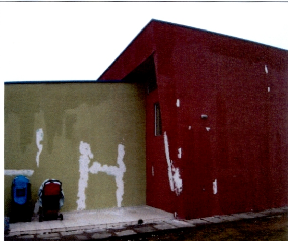
2. Superficie de muro exterior Jardín "Villa Francia"
