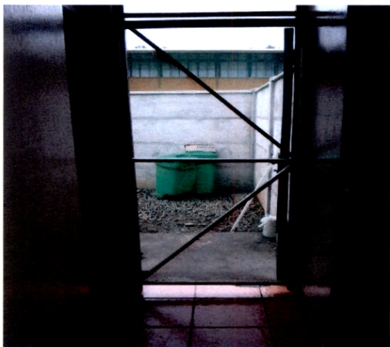
21. Malla que cubre puerta de la cocina no tapa completamente el espacio Jardín "Niños de mi pueblo"
