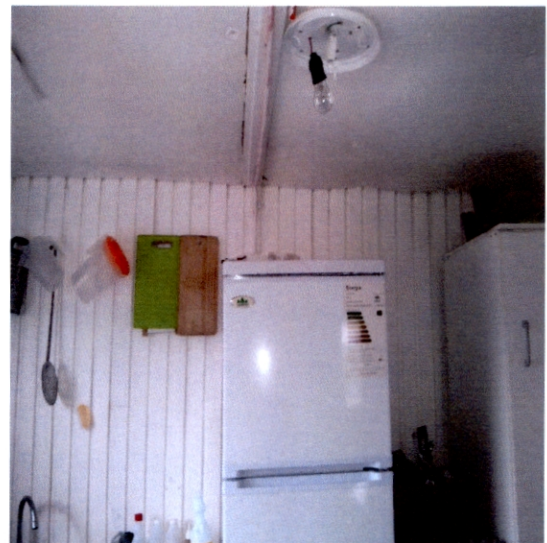
4. Equipo de iluminación de cocina sin pantalla hermética Jardín "Pelusita"
