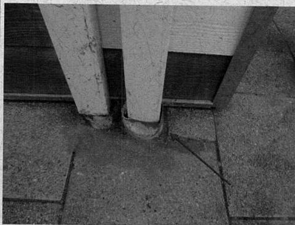
Fotografía N° 20, 2-08-16: Detalle bajada de agua lluvia, Cartagena- San Sebastián.
