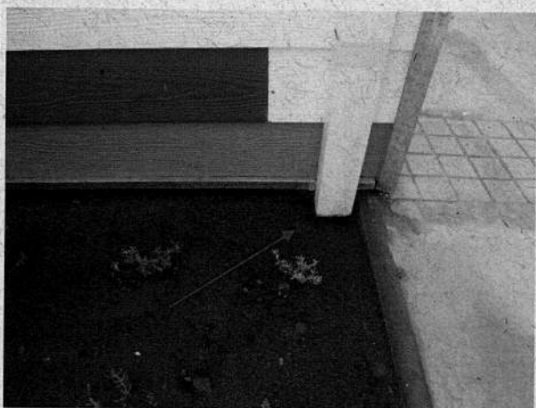
Fotografía N° 21, 02-08-16: Detalle bajada de agua lluvia, Cartagena- San Sebastián.
