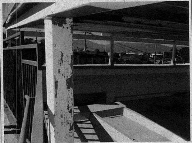
Fotografía N° 16, 9-08-16: Pintura intumescente estructura metálica, Loma Linda, Villa Alemana.
