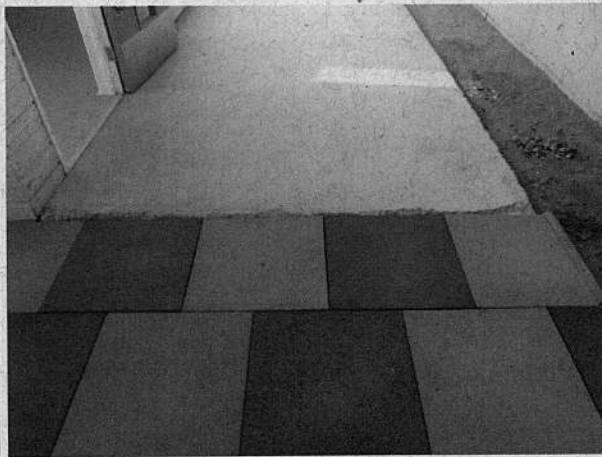
Fotografía N° 27, 16-08-16: Pavimentos en distintos niveles. El Polígono, Nogales.
