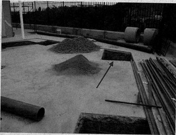
Fotografía N° 7, 24-08-16: G 5.1, Fundaciones de sombreadero y juegos, San Columbano, Valparaíso.
