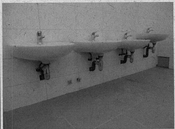
Fotografía N° 30, 11-08-16: Llaves de paso para cada artefacto y para la red fría y caliente.
