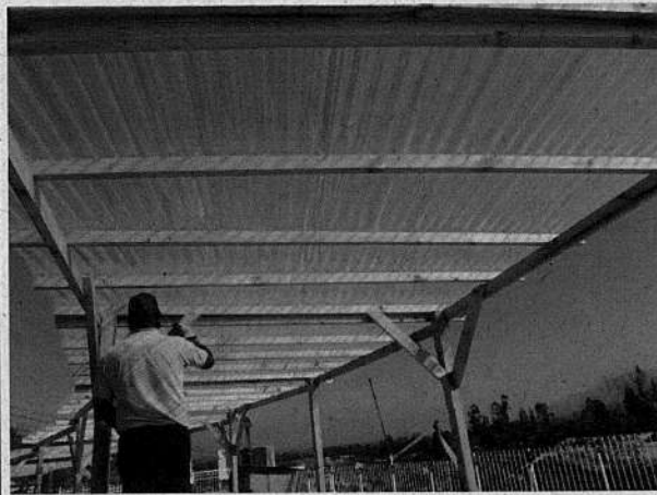
Fotografía N° 29, 11-08-16: Cubierta traslucida tipo PV4, Villa olímpica, Olmue.
