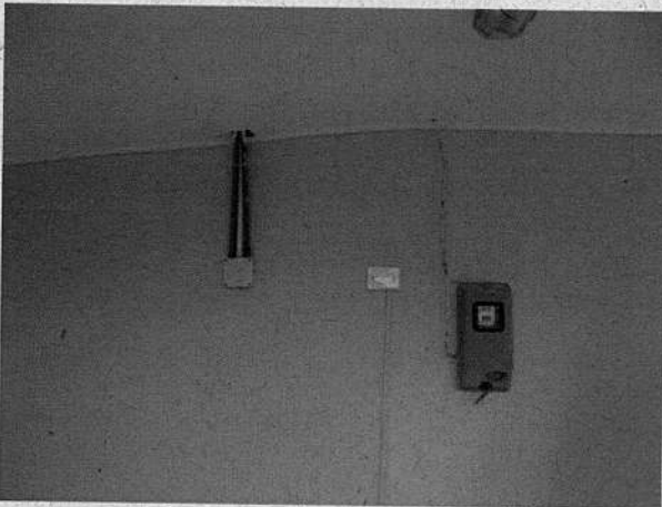
Fotografía N° 11, 24-08-16: F 5.0, Traslado de empalme eléctrico.
