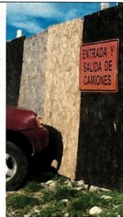
Fotografía N° 6, cierre provisorio, se constató que la placa de material OSB, no se encuentra totalmente pintada.
