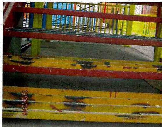
Fotografía N° 3 – 19/7/2016: Escalera en ejecución, obra Antakari
