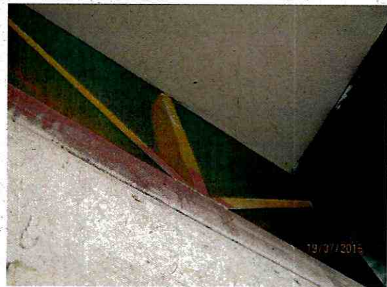
Fotografía N° 2 – 19/7/2016: Pinturas anticorrosiva en ejecución, intumescente no aplicada, obra Antakari.
