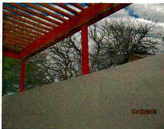
Fotografía N° 18 – 19/7/2016 Estructura de sombreadero instalada sobre muro medianero.
