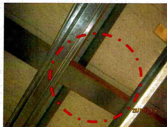
Fotografía N° 5 – 29/7/2016: Pintura anticorrosiva incompleta, obra La Pampa.
