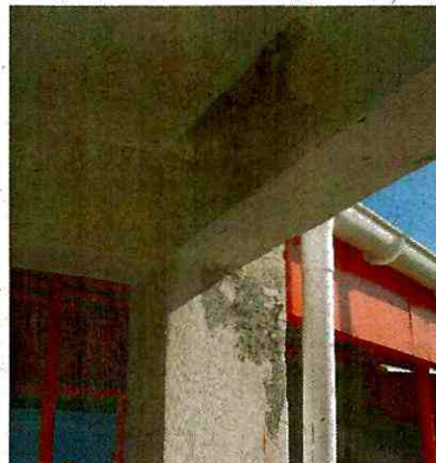
Fotografía N° 2 – 4/8/2016 Obras en ejecución convenio transferencia Jardín Infantil Bellamar Coquimbo.
