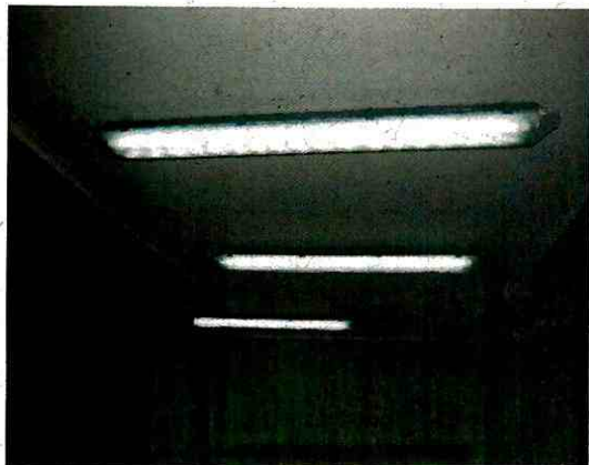
Fotografía N° 13 – 9/7/2016 Omisión equipo fluorescente recinto Cocina Sala de Cuna, obra La Cantera.
