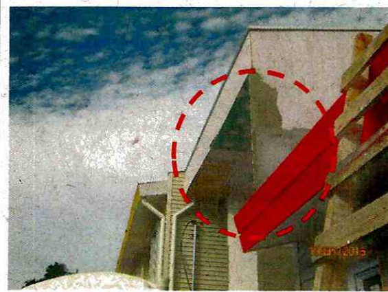
Fotografía N° 1 – 19/7/2016: Pinturas base agua en ejecución, obra Antakari
