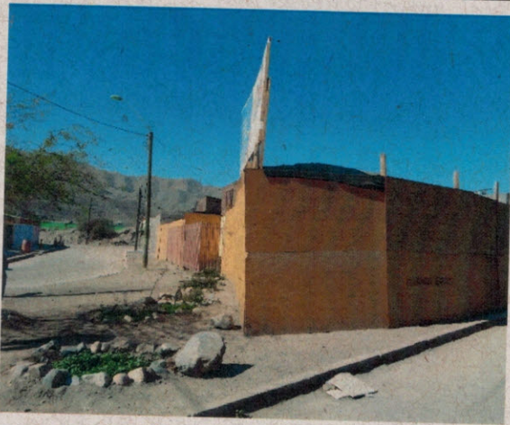
Fotografía N° 38: Cierre provisorio no pintado, JI Las Flores.
