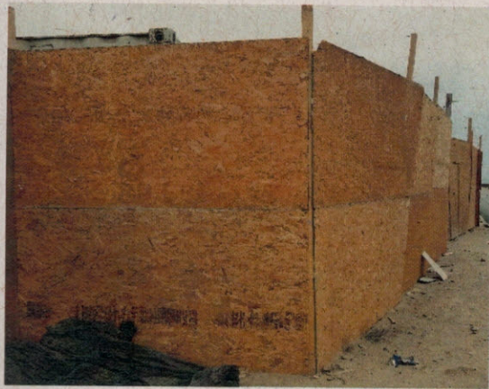
Fotografía N° 44: Cierre provisorio no pintado, JI Aeropuerto.
