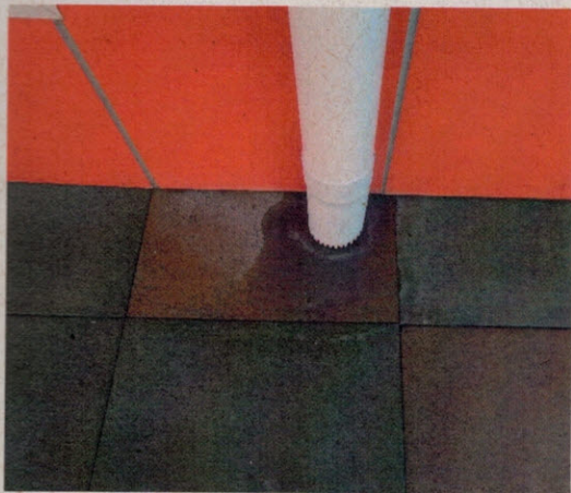
Fotografía N° 22: Bajadas de aguas lluvias sobre pavimento de goma, JI Rahue.
