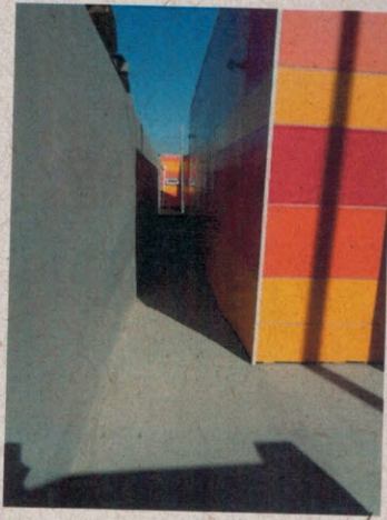
Fotografía N° 36: Falta de reja en vía de evacuación, JI Rahue.
