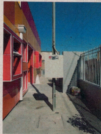
Fotografía N° 23: Bajadas de aguas lluvias sobre pavimento de hormigón, JI Rahue.
