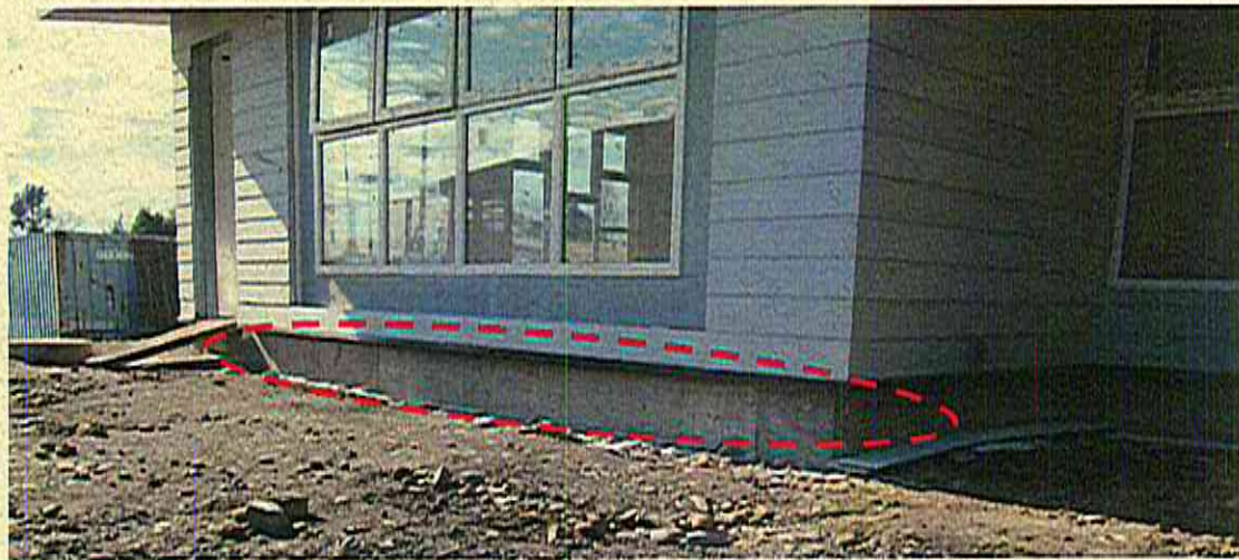
Fotografía N os 5 y 6: C.4.4 Sobrecimiento: Aislación continua, Construcción sala cuna y jardín infantil La Puntilla, Freire.
