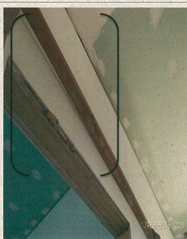
Fotografía N° 11: Vista Tabique interior desalineado.
