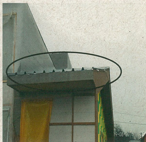
Fotografía N° 10: Vista pendiente de cubierta y terminación en alero..
