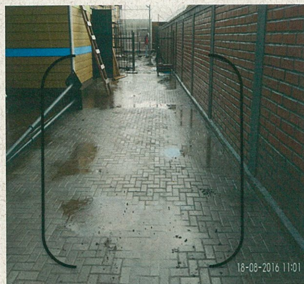
Fotografía N° 7: Pavimento de adoquines
