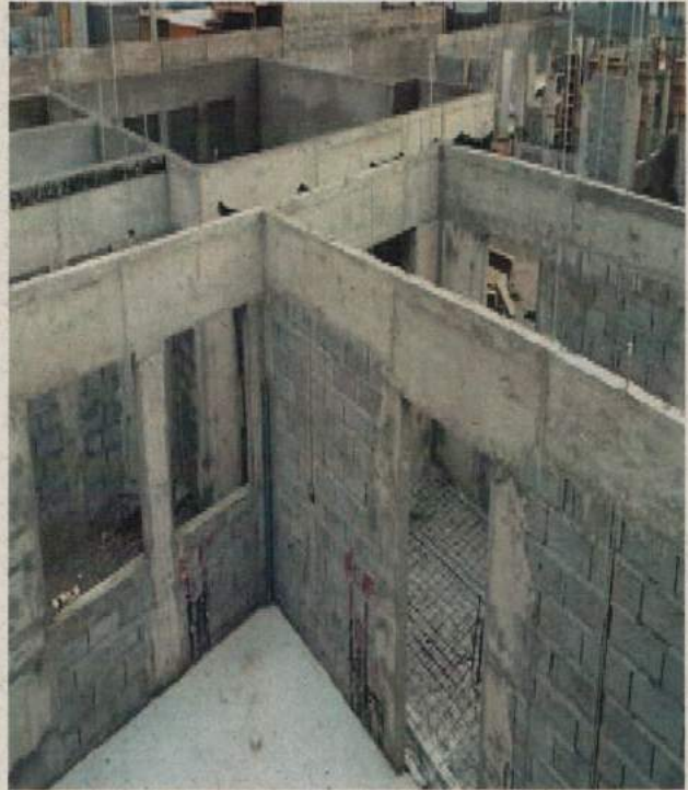
Foto 6: Diseño y Ejecución Sala Cuna y Jardín Infantil Nicolás Tirado, partida pagada no ejecutada, Tabiques interiores de paneles SIP.
