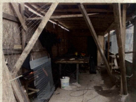
Fotografía N° 6: Vista de la instalación de faenas emplazada sobre bien nacional de uso público. Obra: Construcción Jardín Infantil Don Ignacio, Rauco.
