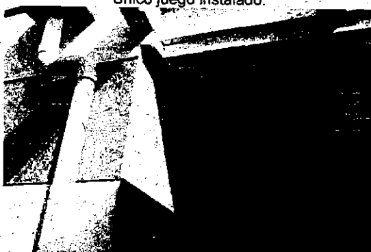
Fotografía N° 15: Contrato "Diseño de Especialidades y Ejecución de Obras de Construcción de Jardín Infantil y Sala Cuna de Chile Chico". Bajada de aguas lluvias en PVC de 75 mm.
